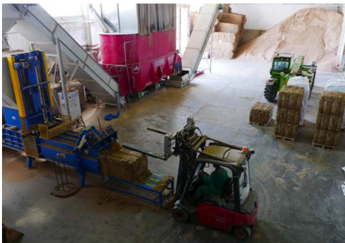
Fanin, vista complessiva del sistema miscelazione e imballaggio.
