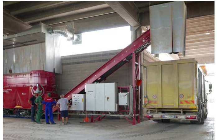
Clavello e Bigarella: al lavoro all'impianto di Pozzoleone (Vi).
